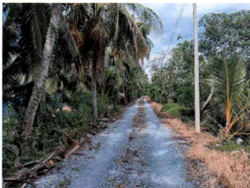
๓.๘ โครงการก่อสร้างถนนลาดยาง สายผู้ใหญ่มงคล กว๊ารักษา หมู่ที่ ๖ ต.คลองจินดา งบประมาณ ๔๗๓,๐๐๐ บาท
